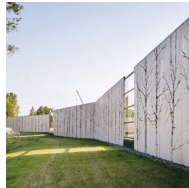
Meluseinät ja tukimuurit
